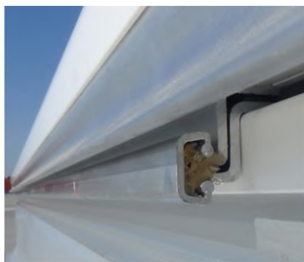
Rys. 21. Zawias z zamontowanym łącznikiem.
