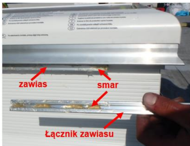
Rys. 18. Smarowanie zawiasu.
