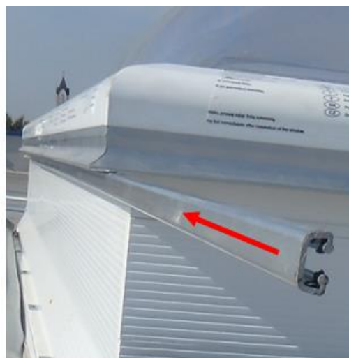
Rys. 19. Nasuwanie łącznika.
