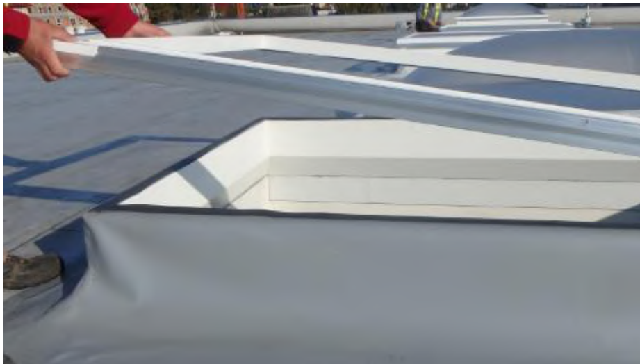
Rys. 10. Układanie wieńca PVC na uszczelce PES.
