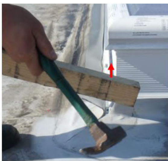
Rys. 20. Nabijanie łącznika.
