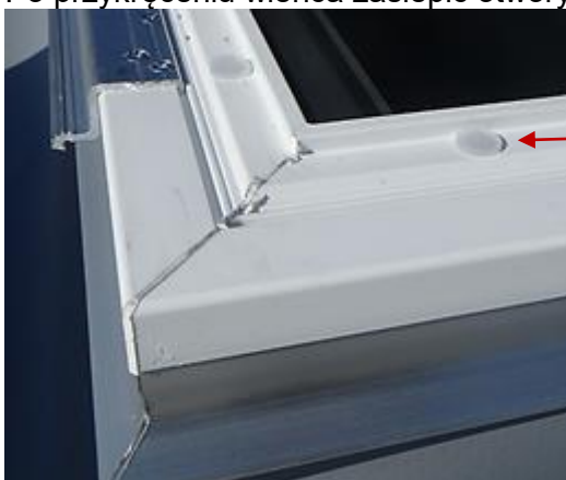
Rys. 12. Montaż zaślepek w wieńcu PVC.
