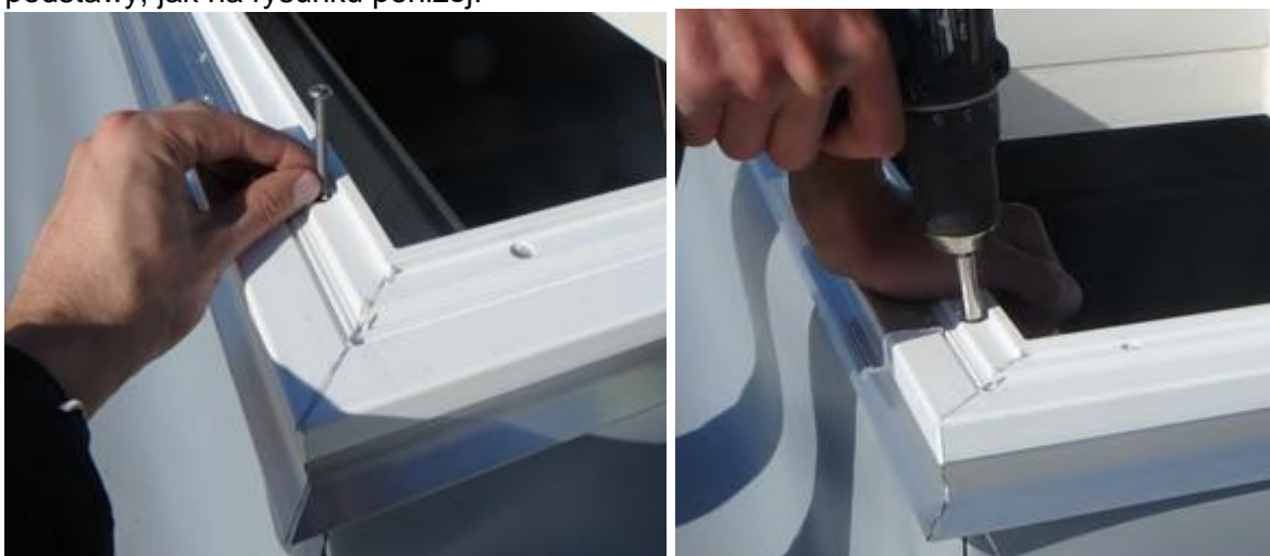
Rys. 11. Przymocowanie wieńca PVC do podstawy metalowej.
