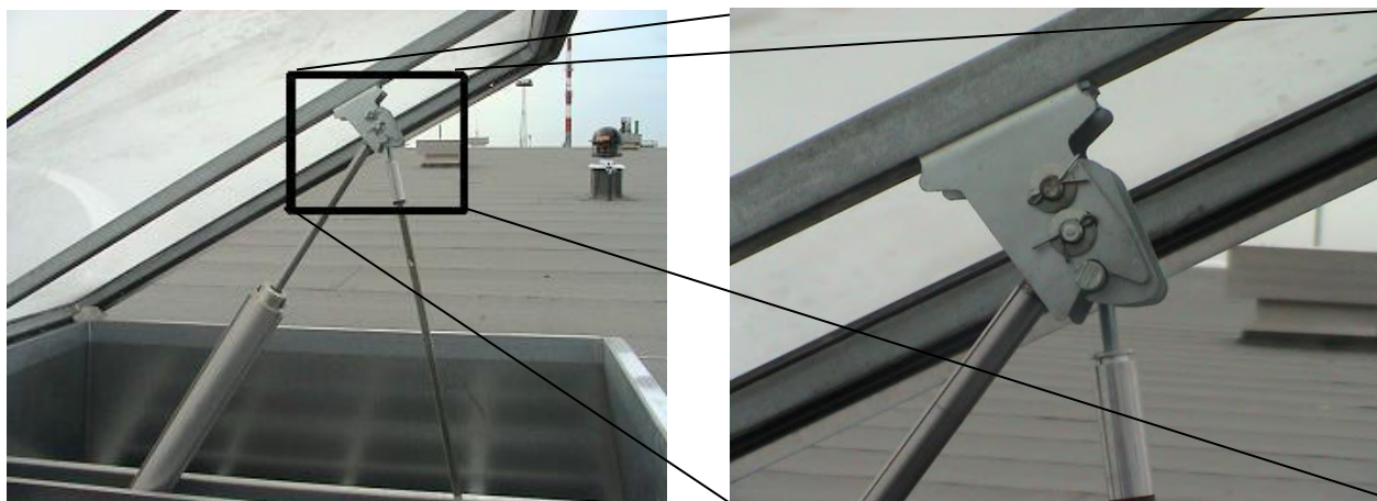
Rys. 28. Połączenie siłowników z konsolą hakową.
